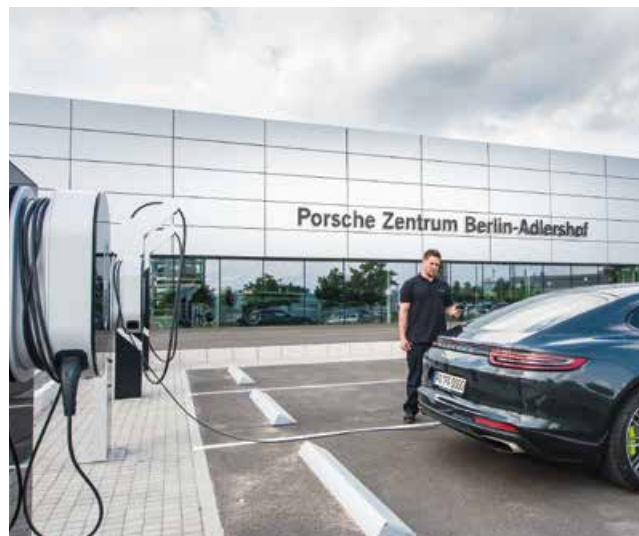
Elektrotankstelle im Porsche Zentrum Electric car charging point at the Porsche Zentrum
