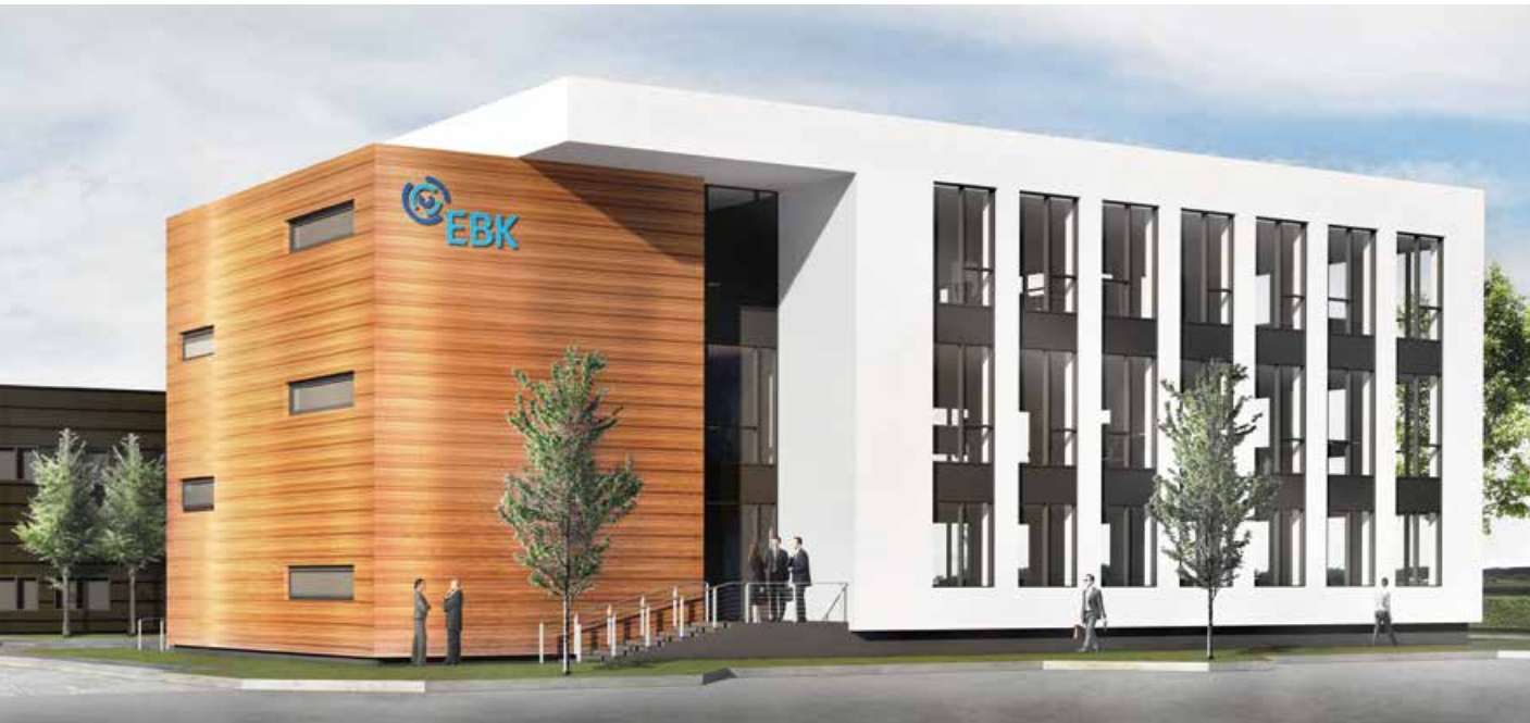
EBK Krüger am Groß-Berliner Damm EBK Krüger on Groß-Berliner Damm
