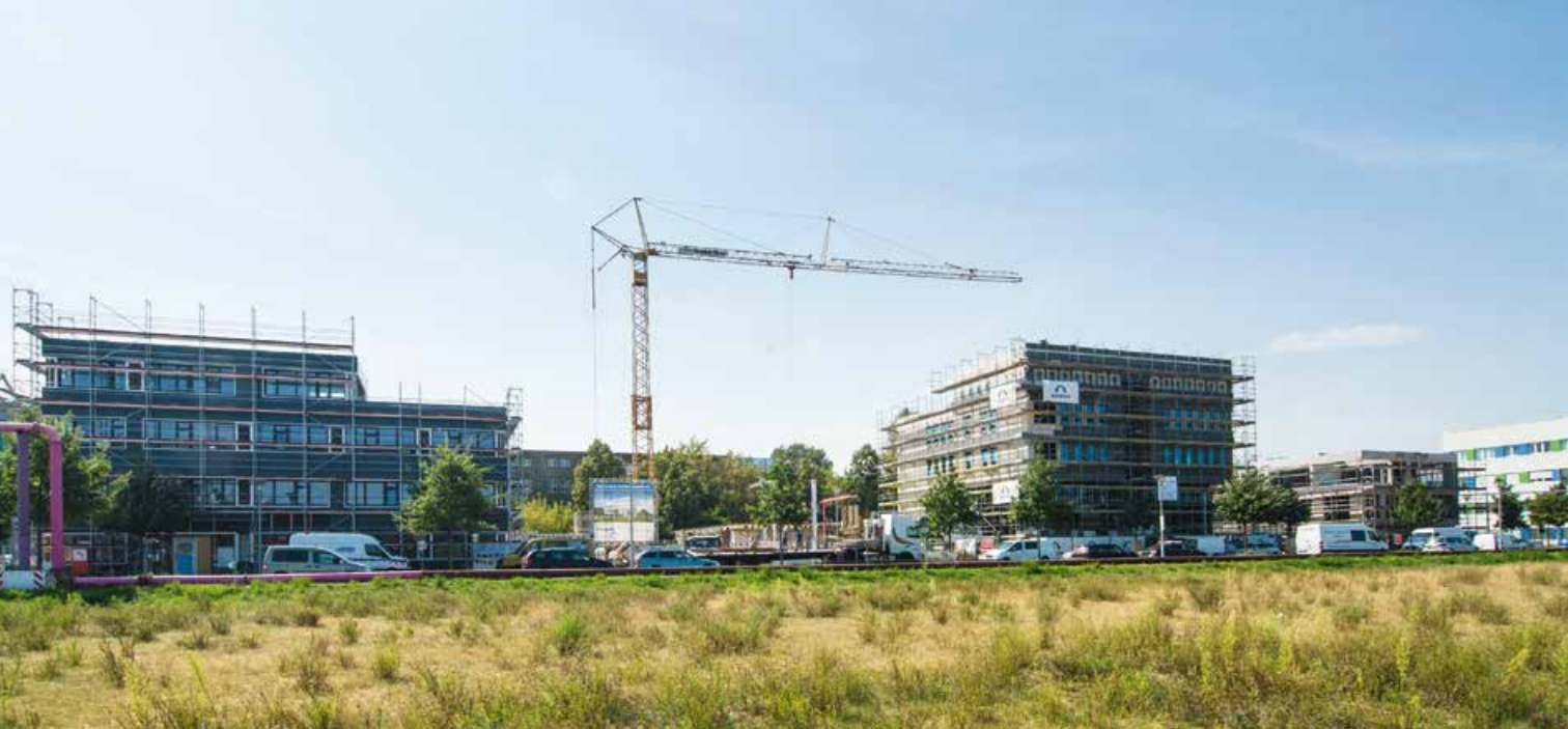
Wagner-Régeny-Strasse: Baustellen von kba, WINDnovation, ZeSys und Vissio Wagner-Régeny-Strasse: Construction sites of kba, WINDnovation, ZeSys and Vissio
